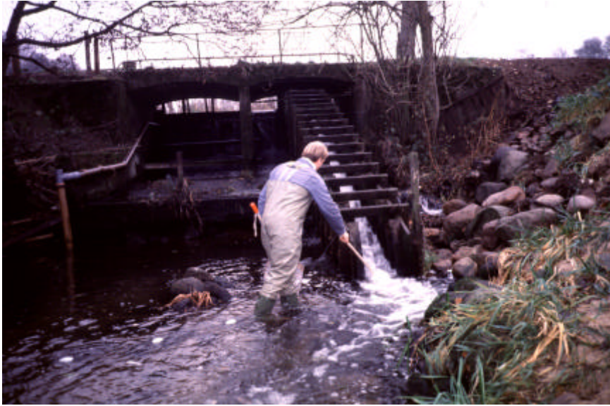
Figur 4.5 Fiskepassagerne ved Årup Mølle Dambrug, Rohden Å.. Øverst fisketrappe af modstrømstypen. Nederst omløb med dobbeltprofil ved lille henh. stor vandføring.
