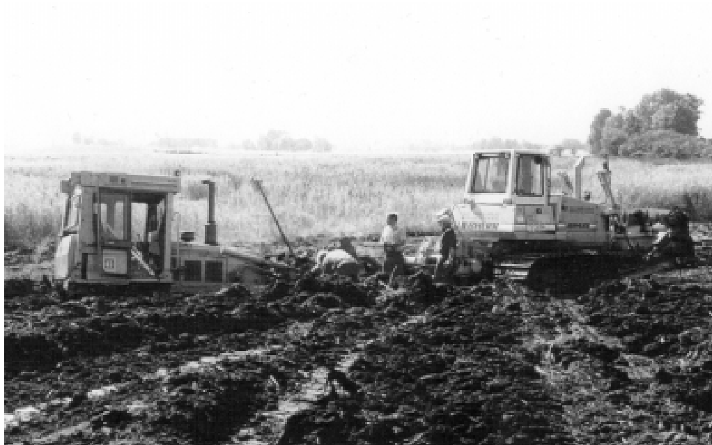
Arbejder på blødbund kan være vanskelige.
