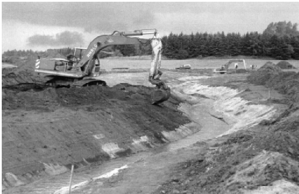
Omlægning af vandløb.
